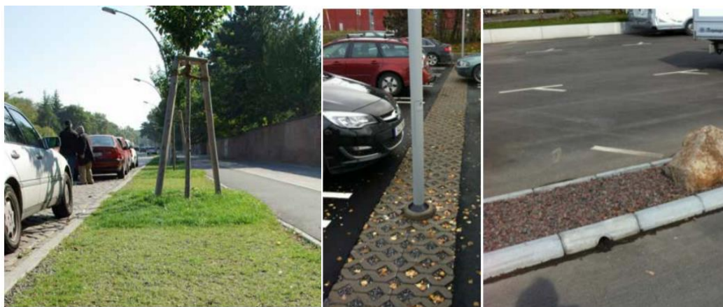
Figur 9. Exempel på infiltrationsyta intill parkering. Till vänster infiltration i grönyta, i mitten infiltration via genomsläpplig beläggning, till höger släpp till makadamdike som infiltrerar till öppet förstärkningslager (Stockholm Vatten och Avfall, 2020c).
