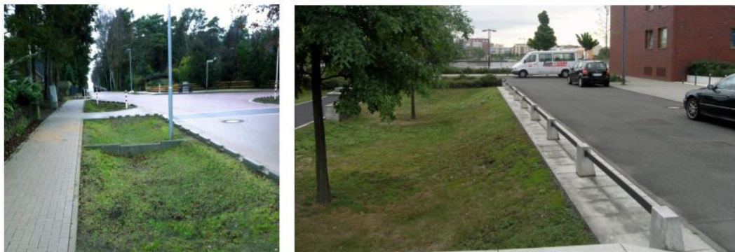
Figur 12. Exempel svackdike (Stockholm Vatten och Avfall, 2020a).
