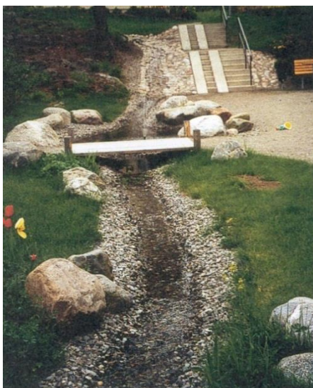
Figur 7. Exempel på ytlig avledning.
